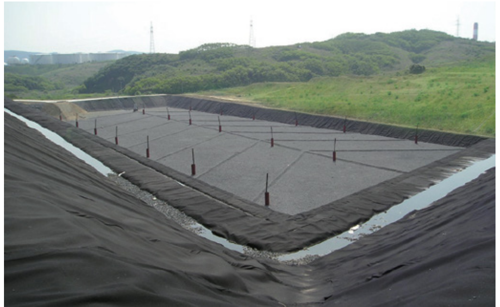
코엔텍 매립장 공사 Koentec Landfill Embankment Project
