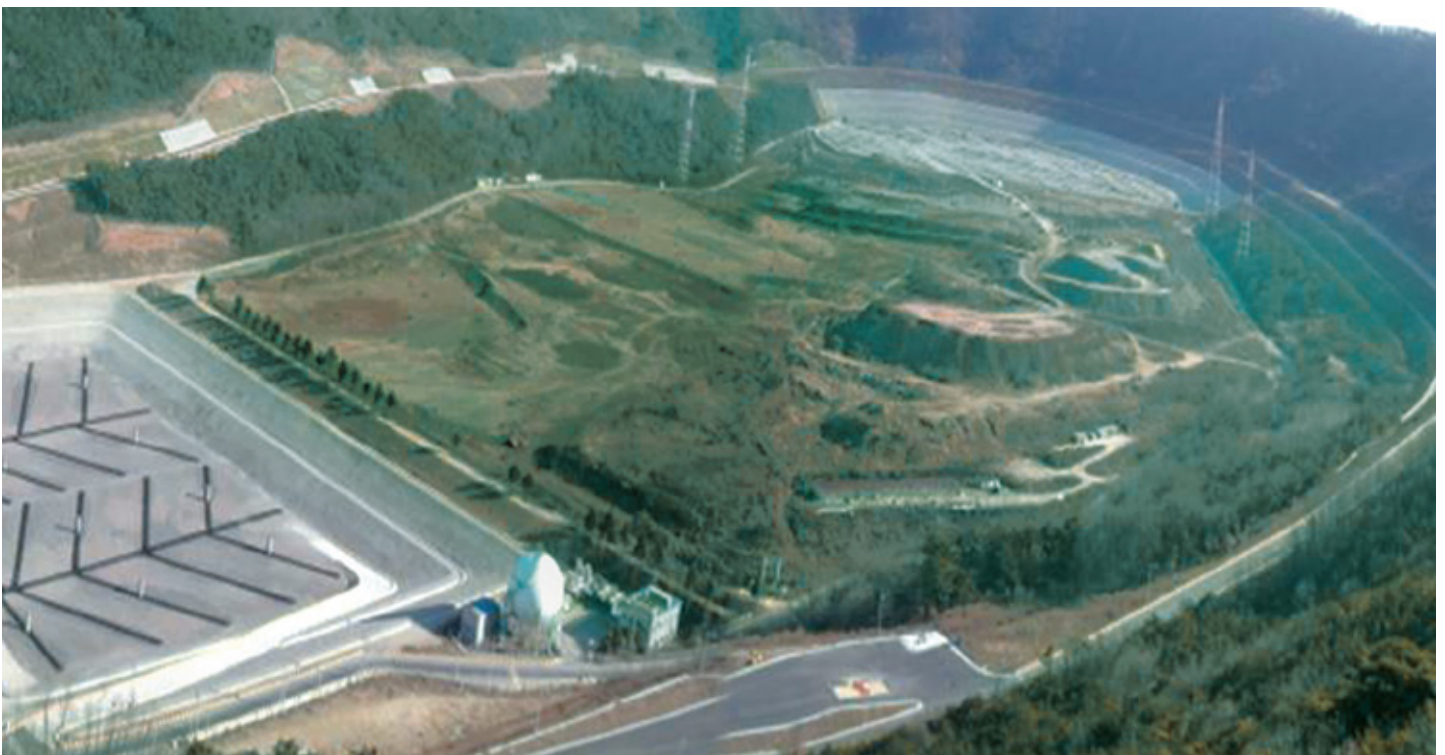
대구 환경 자원 시설 조성 공사 Environmental Resources Project
