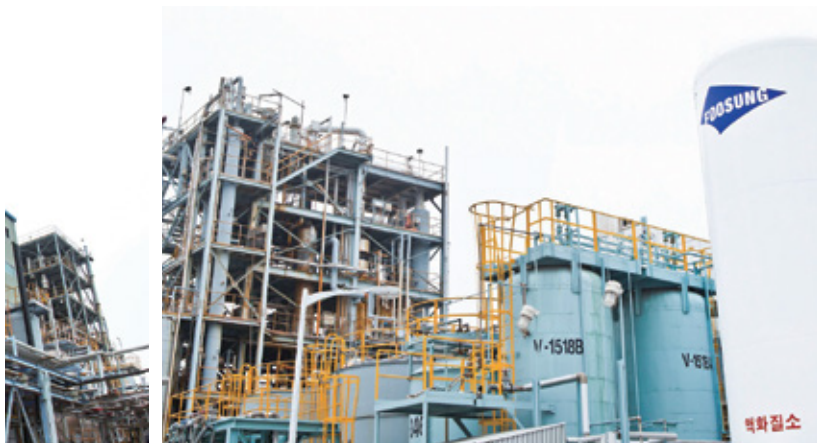
AH6 공장 AHF6 Plant
