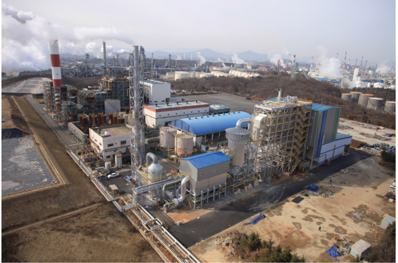
코엔텍K-2 폐자원 열회수 시설 Koentec K-2 Waste incineration and Energy Recovery Facility
