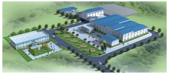
몽골 형석 제련공장 건축공사 Mongol Acidspar Floatation Plant Construction Project
